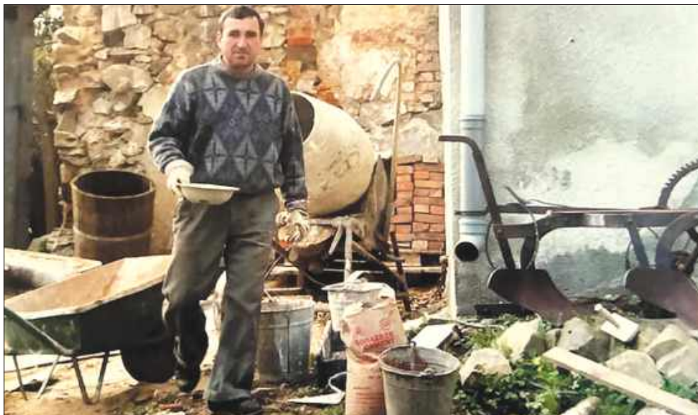
■ Zdjęcie dokumentujące prace przy rozbudowie szkoły muzycznej. Fot. Arch. PSM
