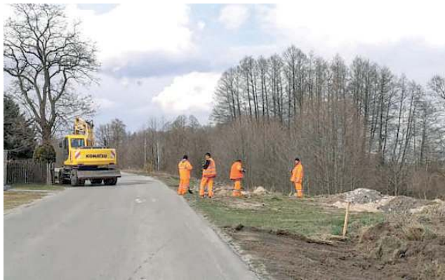
- Pełną parą ruszyła przebudowa drogi gminnej w Łucie, w ramach projektu Mobilny LOF droga zostanie zmodernizowana, powstanie 2,5-metrowa ścieżka rowerowo - piesza, nowa nawierzchnia, zjazdy i pobocza! Oczywiście udało się otrzymać dofinansowanie w wysokości 85% wydatków kwalifikowanych zadania - informował 31 marca wójt Kopyś
