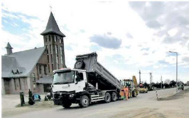
Rozbudowa drogi gminnej Nowodwór - Skrobów- Kolonia. Powstają ścieżki rowerowe i poszerzenie drogi
