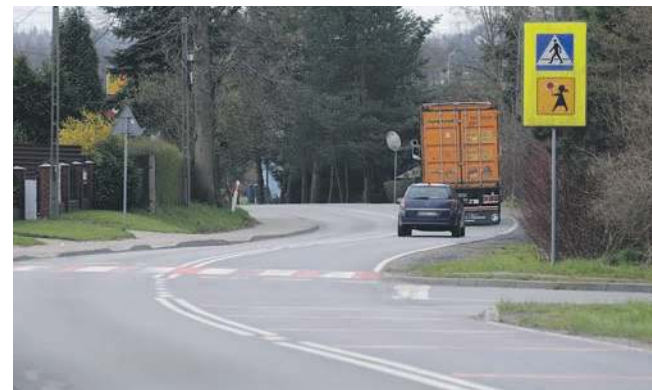
Budowa chodnika wzdłuż Szpitalnej w Chrzanowie, w sąsiedztwie stawu w Kościelcu, została zgłoszona do Budżetu Obywatelskiego Województwa Małopolskiego
