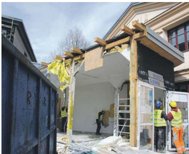
W ubiegłym tygodniu trwały prace wyburzeniowe
