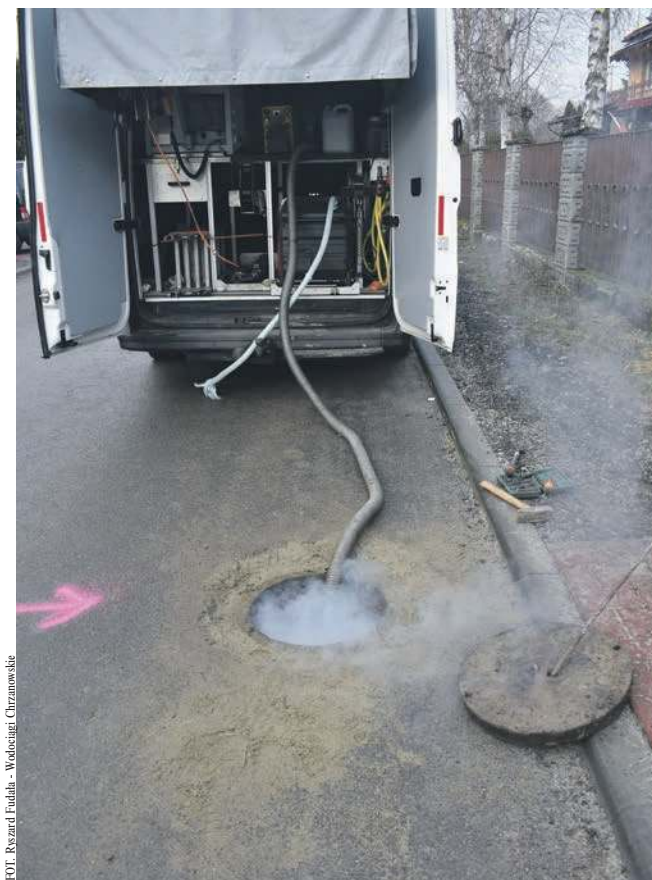
(E) Sprawdzanie szczelności kanalizacji metodą zadymania
