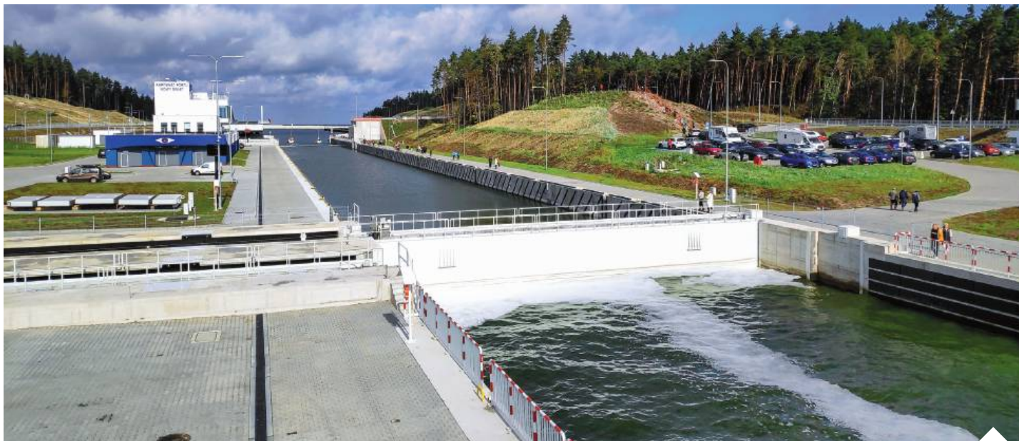
Przekop Mierzei Wiślanej i budowa nowego toru żeglugowego z portu morskiego w Gdyni do portu w Elblągu były jedną ze sztandarowych obietnic wyborczych z 2015 r. Prawa i Sprawiedliwości w obszarze inwestycji infrastrukturalnych | fot. Jan Naj/Gazeta Polska
