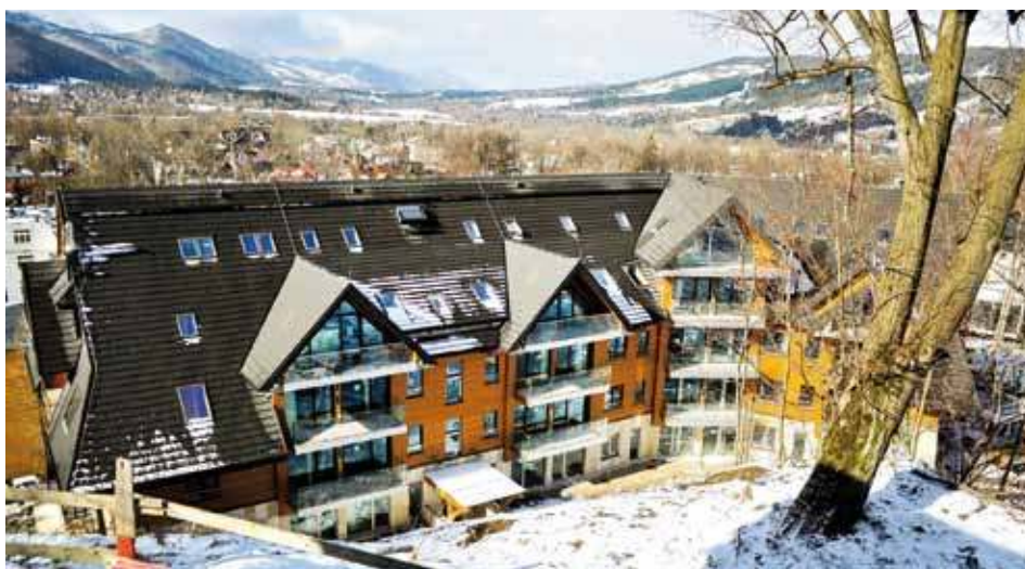
Budynki górują nad kilkoma blokami i domami jednorodinnymi usytuowanymi przy Bulwarach Słowackiego.
