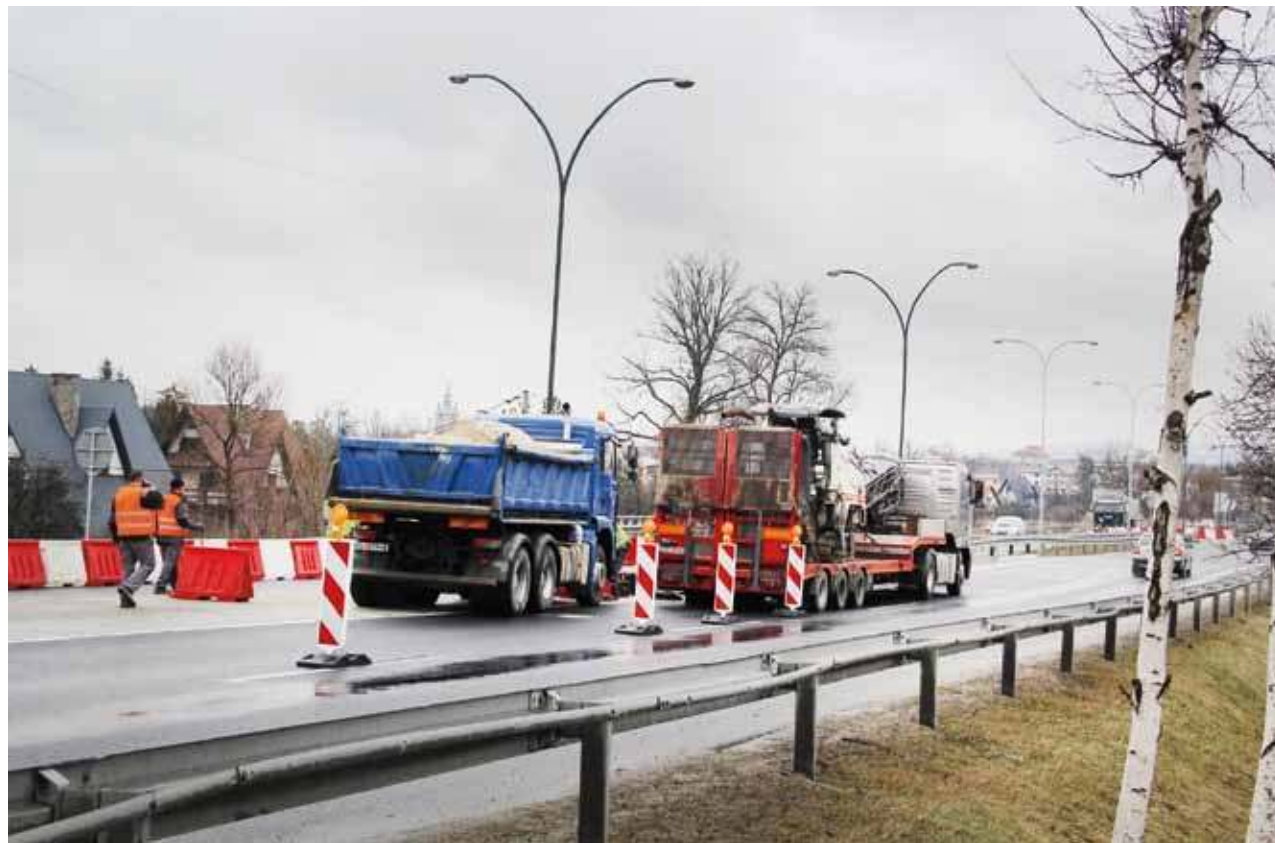
Od poniedziałku przejazd prawym pasem zakopianki nad ul. Grel jest już zamknięty.
