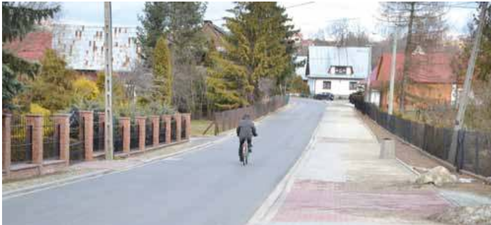
Ulica Orkana jest po przebudowie.
