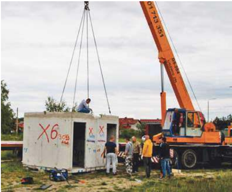
Obecnie trwa sprzątanie zbiornika i placu wokół akwenu
