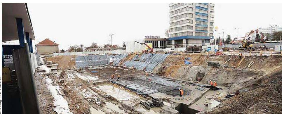
Prace przy budowie nowego dworca kolejowego trwają. Przy dawnym dworcu PKS nic się nie dzieje
