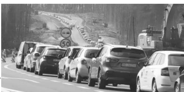
Wylot z Olsztyna zostanie przebudowany
