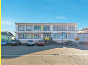
Dom handlowy w samym centrum Janowa Podlaskiego, 885 851 161
