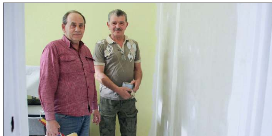
Dostosowaniem pomieszczeń na pracownię endoskopową zajęli się pracownicy szpitala Roman Sosnowski i Jan Gajaszek
