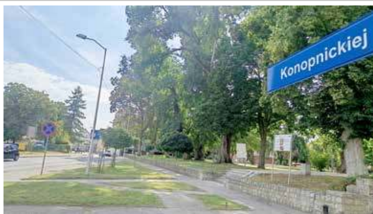
Będzie remont na Konopnickiej
