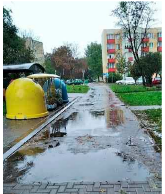
Po deszczu na chodniku tworzy się wielka kałuża
