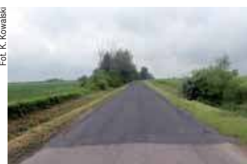
Nowo położona nakładka asfaltowa zakryła największe dziury
