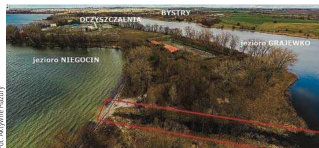
Wody Polskie udrożnią dla żeglugi m.in. kanał łączący jeziora Niegocin i Grajewko
