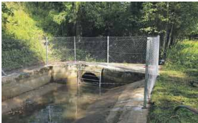
Rurociąg zabezpieczony kratą. Pracownicy zamontowali też ogrodzenie.
