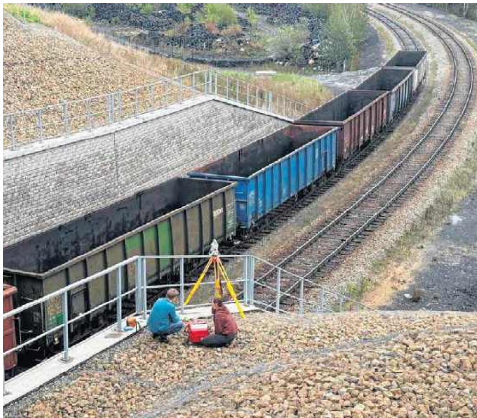
Wiadukty na ulicy Pszczyńskiej w Jastrzębiu - Zdroju są sukcesywnie remontowane
