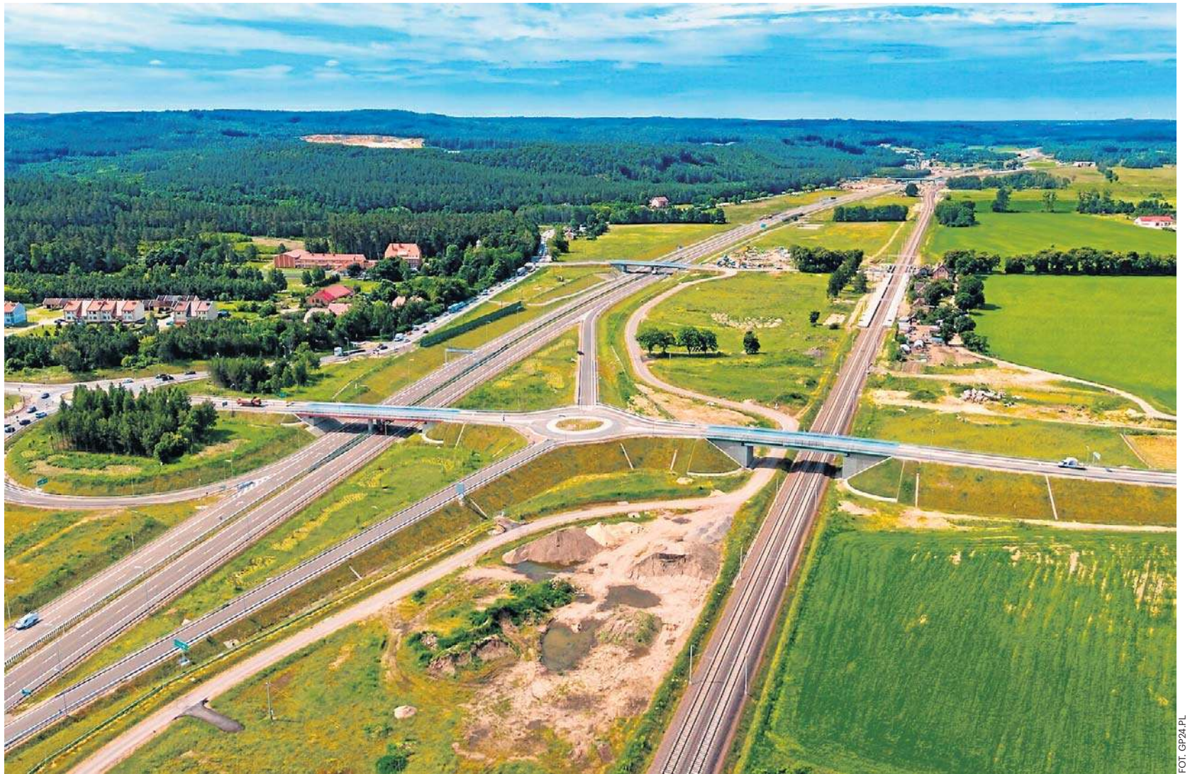
Zwieńczeniem prac było oddanie do użytku 40-kilometrowego, ostatniego brakującego fragmentu S6 z Leśnic do Słupska
