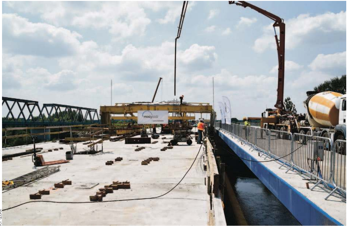
Przed kilkoma dniami zabetonowany został zwornik na lewej jezdni mostu. Tym samym obie nitki mostu połączyły brzegi Sanu
