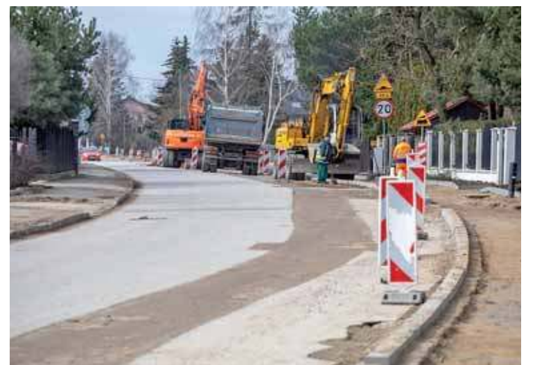
Jedna z tegorocznych płońskich inwestycji – modernizacja ul. Szkolnej
