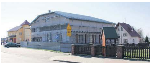
Trwa budowa świetlicy wiejskiej w Majdanie Starym.
