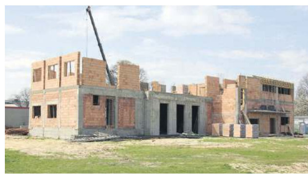
GOK w budowie
