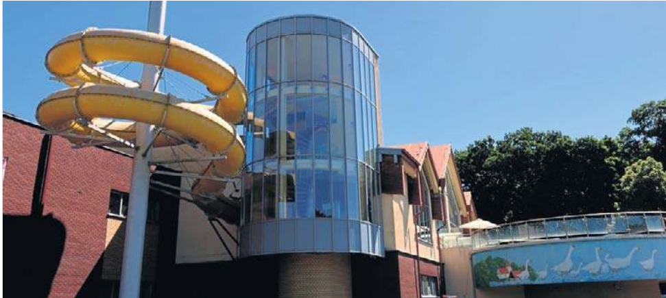
Kompleks Strefa 360 Park Redzikowo przechodzi modernizację
