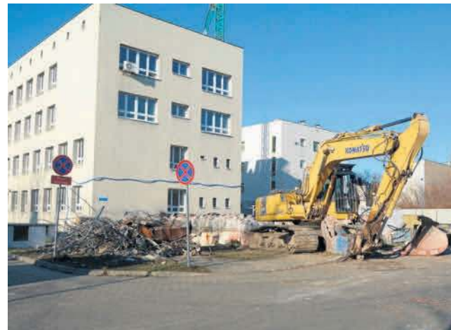
Budowlancy rozebrali budynek pralni przy dawnej ginekologii. Stanie tam nowe skrzydło centrum rehabilitacji.
