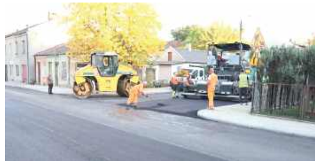
Na ulicach Tadeusza Kościuszki oraz Szkolnej trwa układanie nowych warstw asfaltu. Mieszkańcy od dawna czekali na poprawę stanu tych ulic (fot. Jerzy K. Wojtaś)
