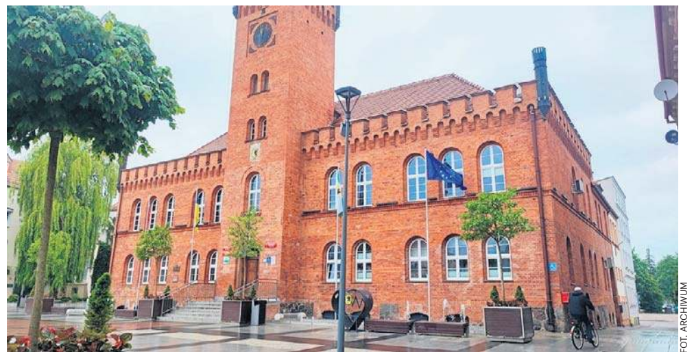
Ratusz już ogłosił przetarg na realizację tego zadania. Po zakończeniu prac docelowo „pod ratuszem” będzie mogło się schronić 106 osób
