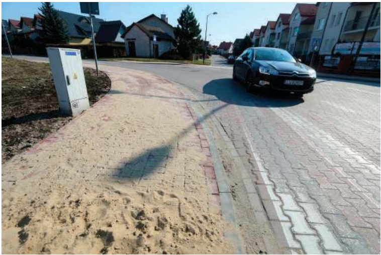
Przy skrzyżowaniu ulic Czecha i Olimpijczyków powstały brakujące fragmenty chodnika
