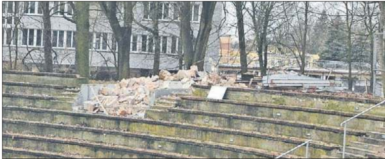
Prace rozbiorowe w amfiteatrze już trwają. Na pierwszy ogień poszła budka obsługi technicznej na widowni
