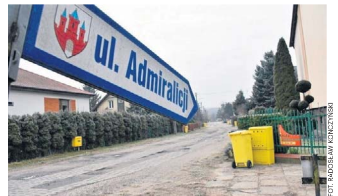
Po większych opadach ulice i posesje na „osiedlu morskim” znajdowały się pod wodą. Tu nie ma burzówki
