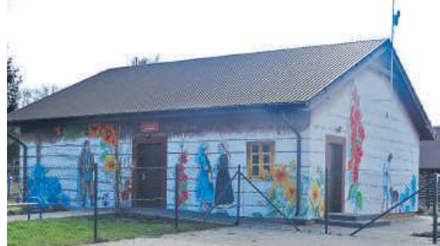
• Świetlica wiejska w Kosyniu
