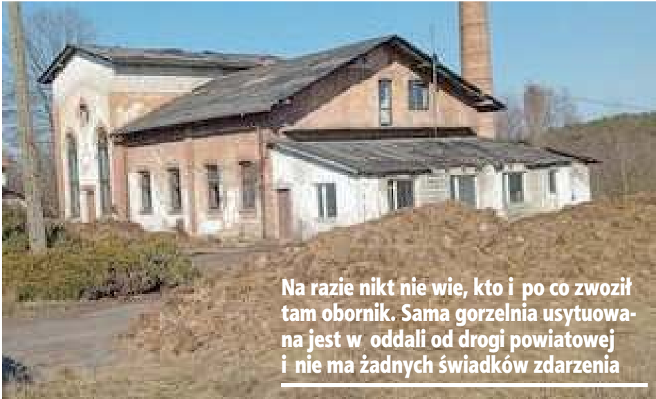
Ktoś z prywatnego terenu urządził sobie składowisko odpadów
