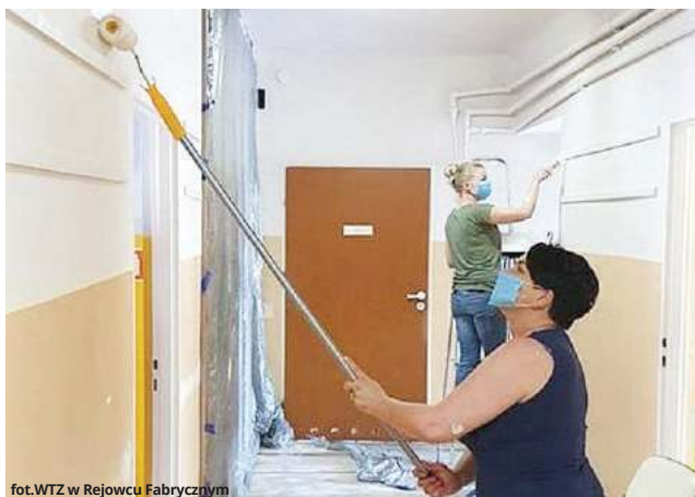
Gdy zajęcia były zawieszane pracownicy WWTZ w Rejowcu Fabrycznym przeprowadzili remont pomieszczeń
