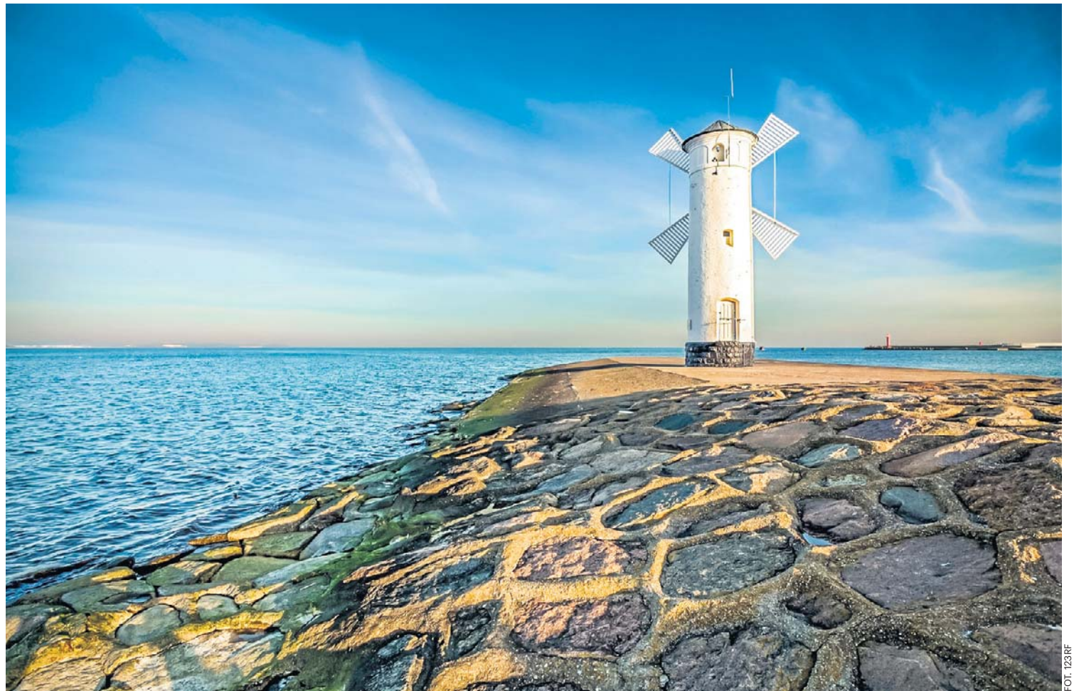
Wiatrak w Świnoujściu pochodzi z XIX wieku i od samego początku jest ważnym punktem nawigacyjnym w tej części Bałtyku
