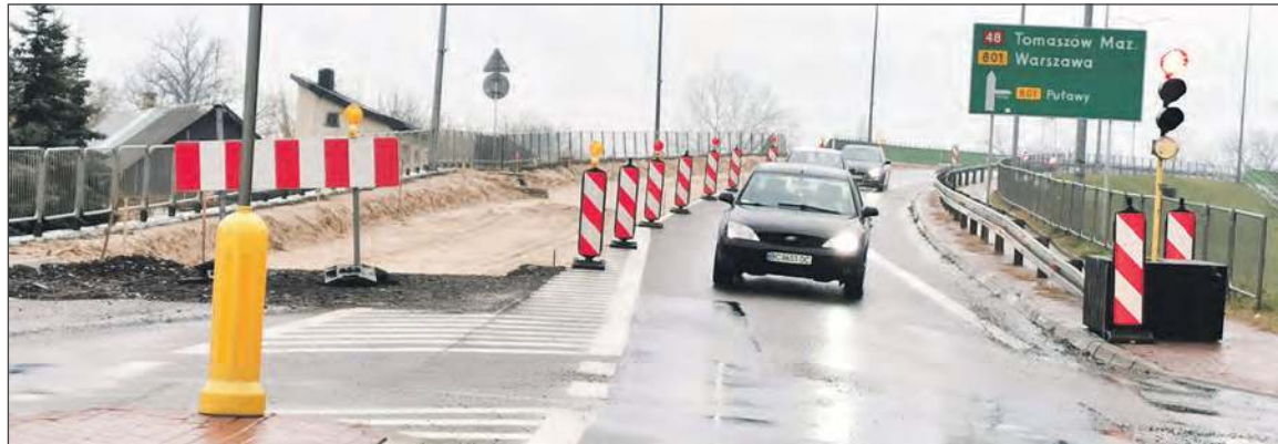
Na czas przebudowy wiaduktu nad torami kolejowymi wprowadzono ruch wahadłowy, sterowany tymczasowo sygnalizacją świetlną. Niestety od ponad trzech tygodni prace na wiadukcie zostały wstrzymane
