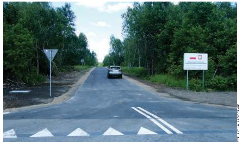
Nowa droga w Domostawie otwiera kolejne tereny pod budownictwo jednorodzinne
