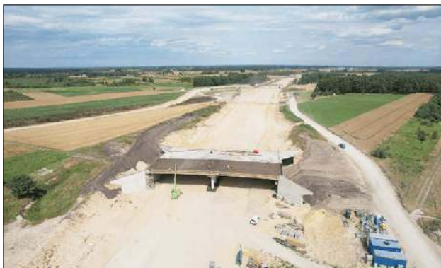
W realizacji jest obecnie 101 kilometrów trasy od końca obwodnicy Mińska Mazowieckiego do węzła Biała Podlaska
