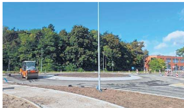
W piątek na rondzie u zbiegu ulic Legionów i Polnej trwało jeszcze asfaltowanie przed udostępnieniem dla ruchu
