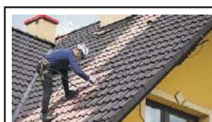
MALOWANIE DACHÓW. Tel. 504 043 310.
