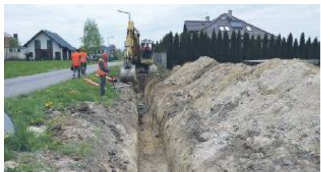
Przebudowa oczyszczalni ścieków w Żmudzi
