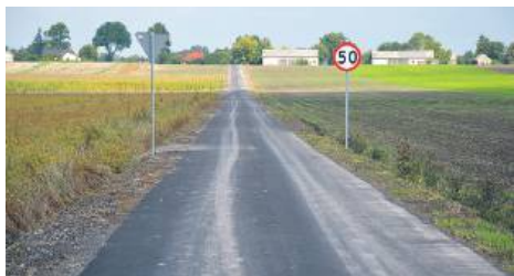
Przebudowa drogi dojazdowej w Żmudzi
