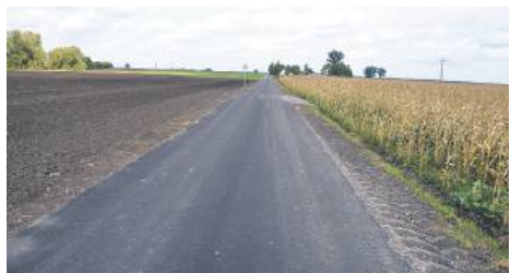
Przebudowa drogi w Klesztowie
