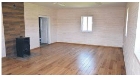
Remont sali w Izbie Regionalnej w Stanisławowie
