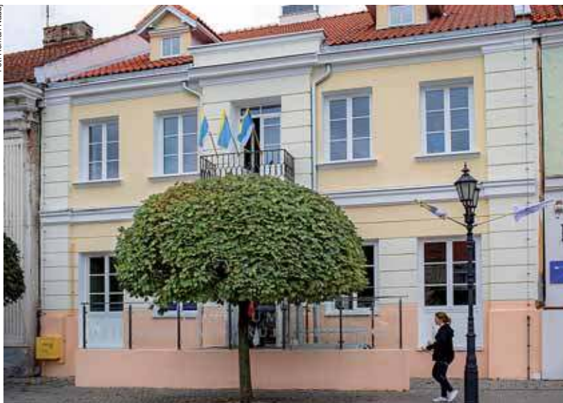
Odnowiona kamienica przy ul. Rynek 13
