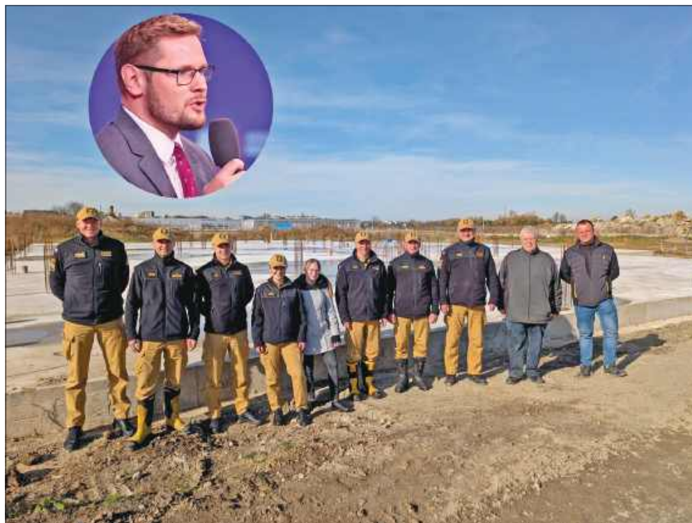
■ Oficjalne spotkanie delegacji Komendy Powiatowej PSP w Raciborzu z przedstawicielami firmy wykonawczej – raciborskiego Borbudu. Dokonano odbioru pierwszego etapu budowy
