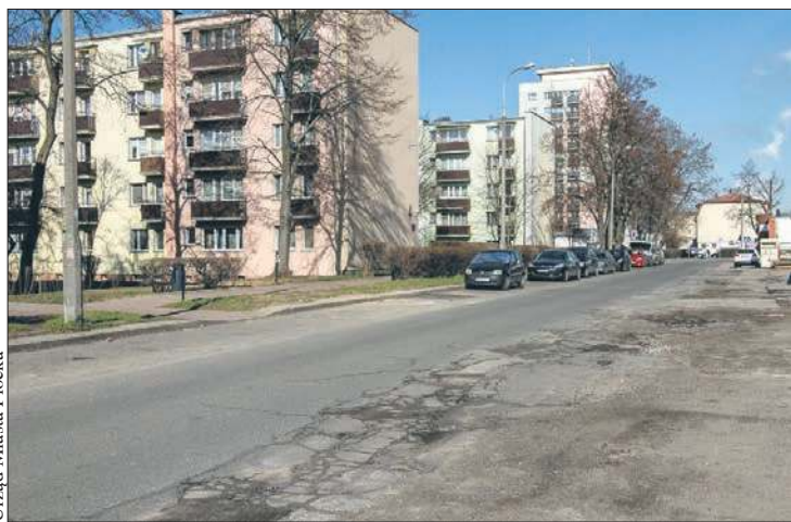
Ulica Na Skarpie zostanie przebudowana
