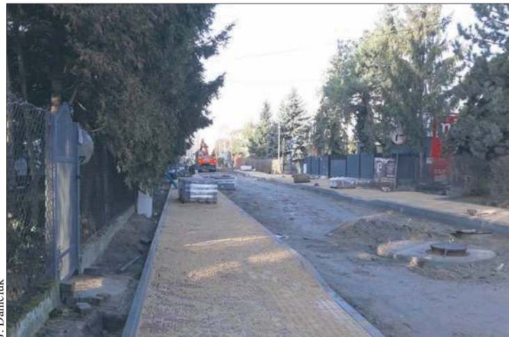
Trwają prace na ulicy Maneżowej
