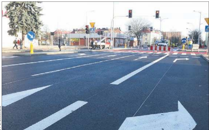
Przebudowany wlot ul. Tysiąclecia w ul. Bielską
