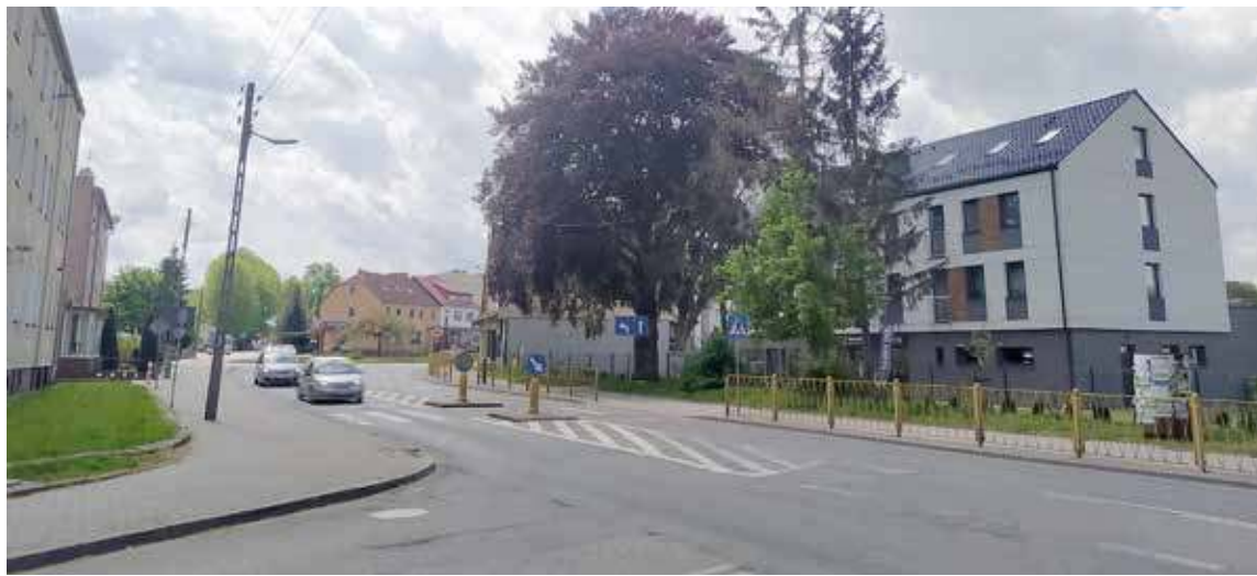
Doświetlone mają być przejścia dla pieszych, m.in., te zlokalizowane na ulicy 3 Maja
