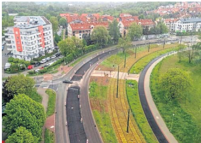
Budowa linii tramwajowej do Mistrzejowic ma zakończyć się do 31 sierpnia 2026
