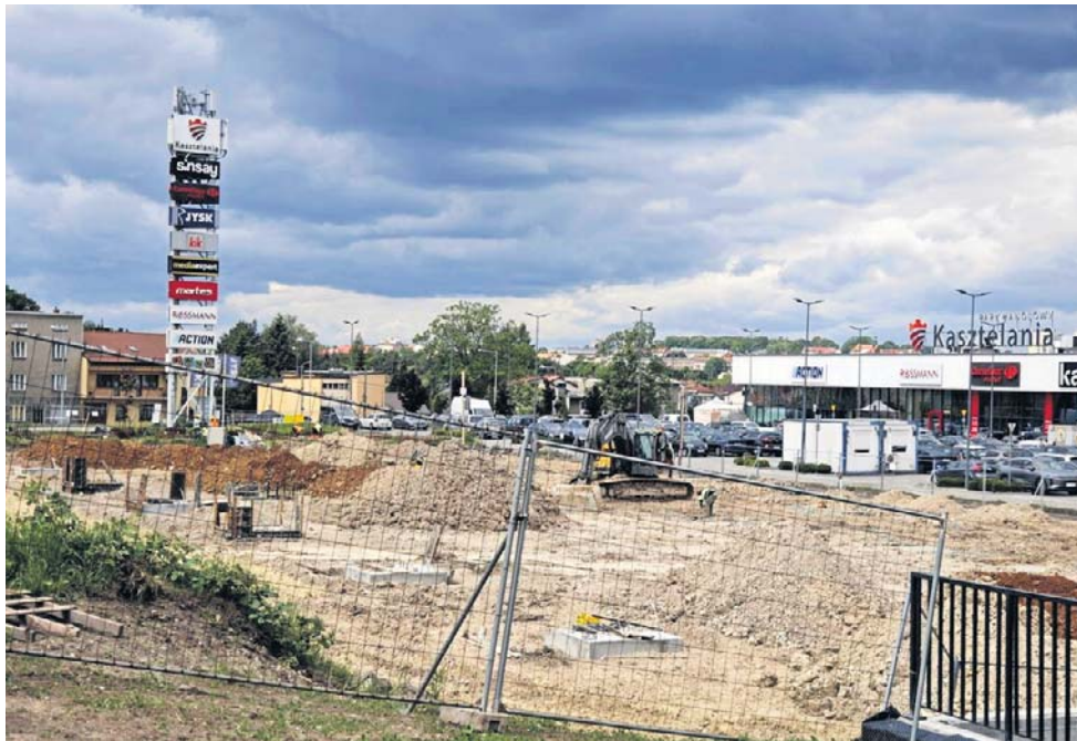
Rozpoczęła się budowa Castoramy w Chrzanowie. Trwa inwestycja przy Kasztelanii
