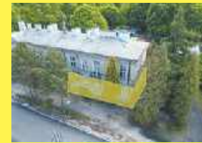
Mieszkanie o powierzchni 83 m 2 z garażem i 2 wejściami, ul. Kościuszki w Białej Podlaskiej, 885 851 160
