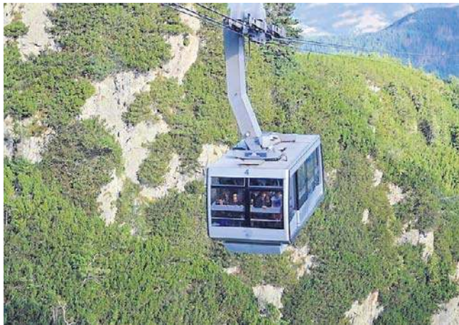
Jesienny przegląd techniczny to standardowa procedura, którą PKL przeprowadza co roku
