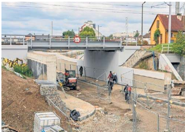
Ulica Kolejowa w Nowym Sączu w końcu będzie otwarta dla ruchu. Trwają ostatnie prace
