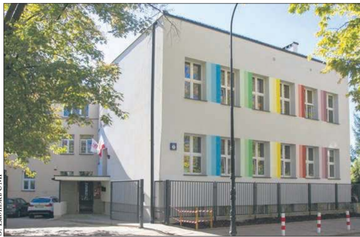
W listopadzie zakończą się prace modernizacyjne przy Miejskim Przedszkolu nr 33
