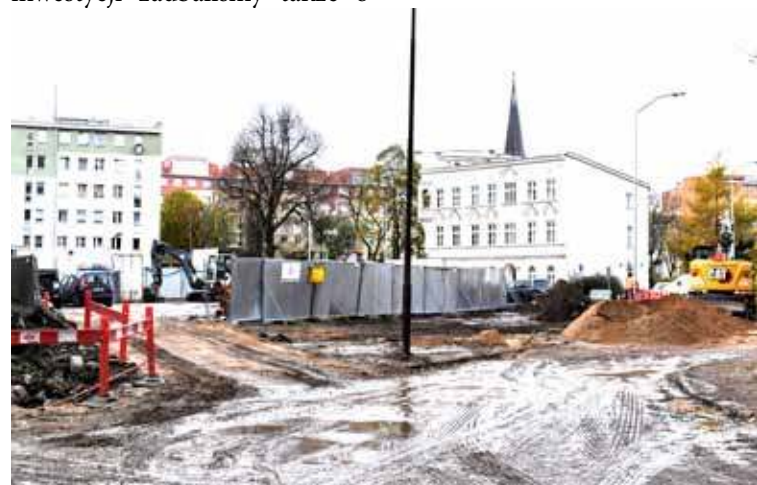
W ramach prac przygotowywane są m.in. nowe miejsca parkingowe
