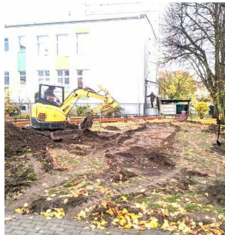
Obecnie trwają prace ziemne
