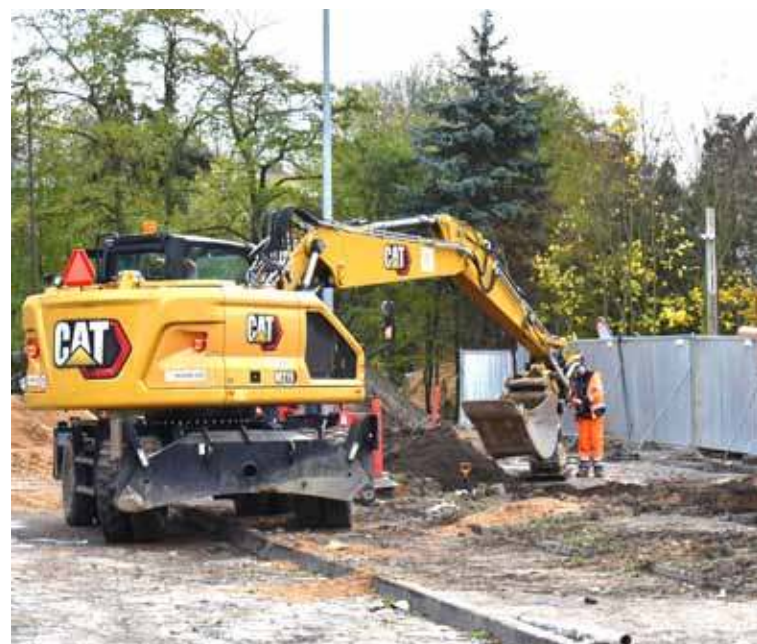
Jak zaznacza w swej nocie UM, inwestycja rozpoczęła się od budowy kanalizacji deszczowej
