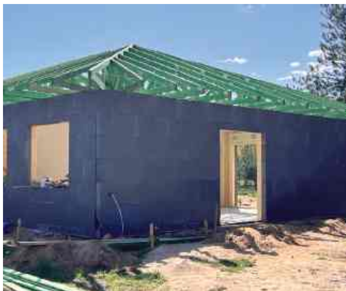
BUDOWA DOMZFABRYKI.EU – ŚCIANA ZAMKNIĘTA DYFUZYJNIE
