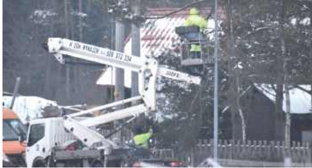
Przedsięwzięcie obejmuje kompleksową modernizację oświetlenia ulicznego na terenie gminy Biłgoraj
