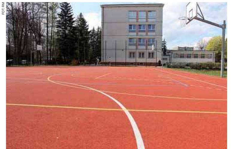
Wyremontowane boisko przy ZS nr 1 w Ciechanowie
